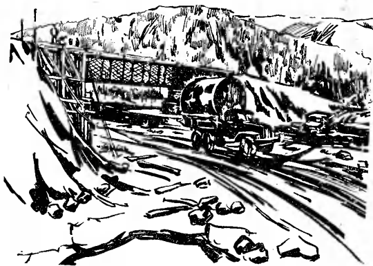
Дорога к Байкальскому тоннелю. Река Гуджигит.
