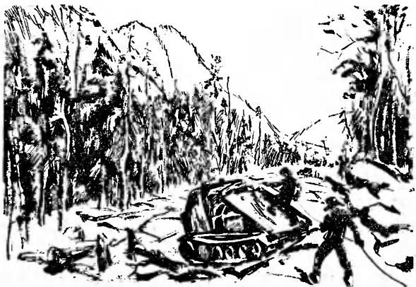
Один из участков строительства трассы под Северобайкальском.
